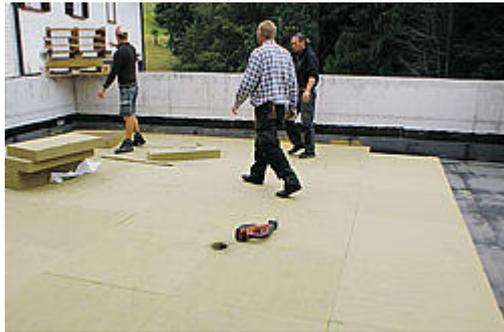
Trittfeste Dämmplatte für den Einsatz in Flachdächern, welche für eine Nutzung durch Personen und/oder für Installationen vorgesehen sind. Als Kerndämmung bei zweischaligen Betonwänden.
