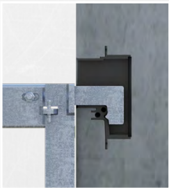
Kontrolle ob die Konsole richtig aufliegt
