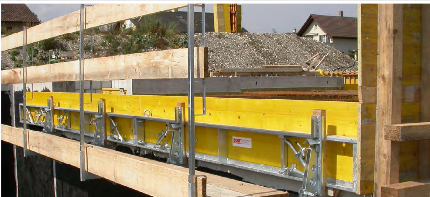
BKA Pro Konsolen mit Maxi-Form und einem Arbeitsgerüst mit Seitenschutz
