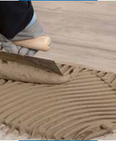
Verlegung von Feinsteinzeugfliesen mit Holzoptik
