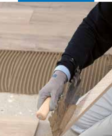
Aufziehen des Klebemörtels im Buttering-Floating-Verfahren
