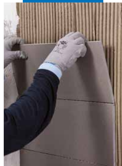
Verlegung von Keramik im Wandbereich
