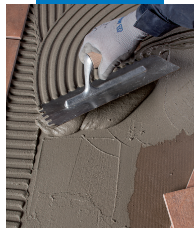
Verlegung der Fliesen mit Elastorapid
