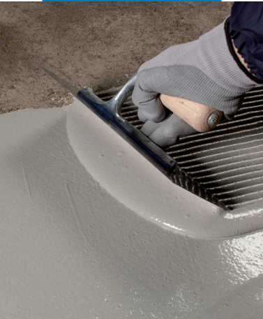
Auftragen der ersten Schicht von Mapelastich Turbo
