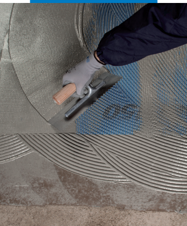
Einbetten von Mapenet 150 in die frische erste Schicht von Mapelastich Turbo
