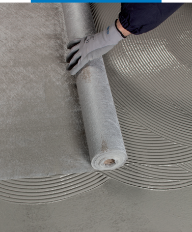
Einbetten von Mapetex Sel in die frische erste Schicht von Mapelastich Turbo
