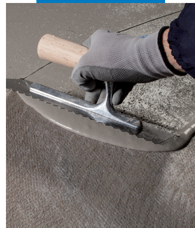
Auftrag der zweiten Schicht Mapelastic Turbo auf Mapetex Sel
