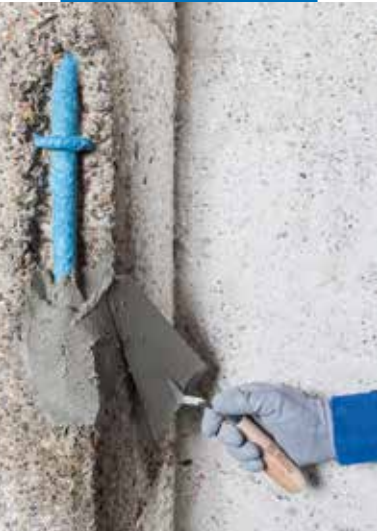
Auftragen von Planitop Rasa & Ripara R4 mit der Kelle
