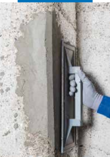
Oberflächenglättung von Planitop Rasa & Ripara R4 mit der Glättkelle
