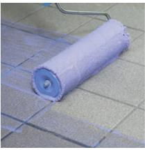
PCI Gisogrund 404 in der Kontrollfarbe violett ermöglicht eine hohe Verbundhaftfestigkeit von Ausgleichsmassen und Verlegewerkstöffen zum jeweiligen Untergrund.
