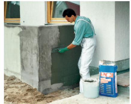
Mit dem schnell härtenden Betonspachtel PCI Polycrret 5 können normal saugende Betonflächen ohne Grundierung in einem Arbeitsgang überspachtelt werden.
