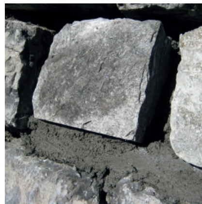
Pavifix CEM ROC in steifplastischer Konsistenz zum Setzen und Verfugen von Naturwerksteinen
