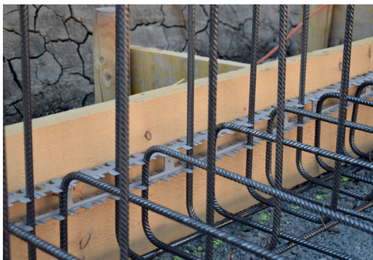
ferrofix wand hält vertikale Eisen mit nur einer Profilstange pro 1m Höhe.
