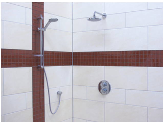
11 Farbbrillante Fugenfläche im Badezimmer.
