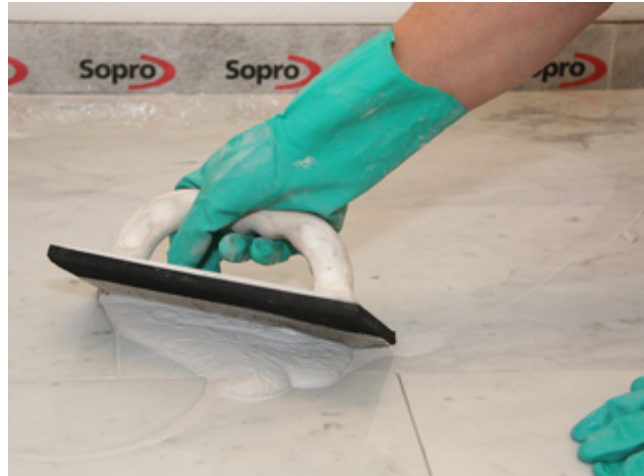
8 Einfugen von Sopro DF 10 in verarbeitungsempfindlichen Naturstein.
