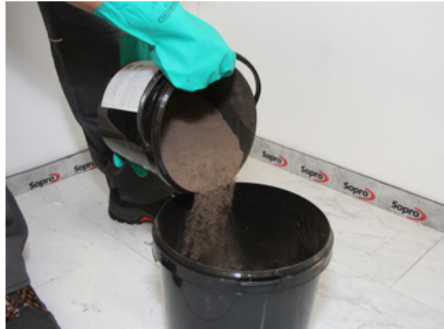
2 Sopro DF 10 zudosieren und maschinell anrühren.
