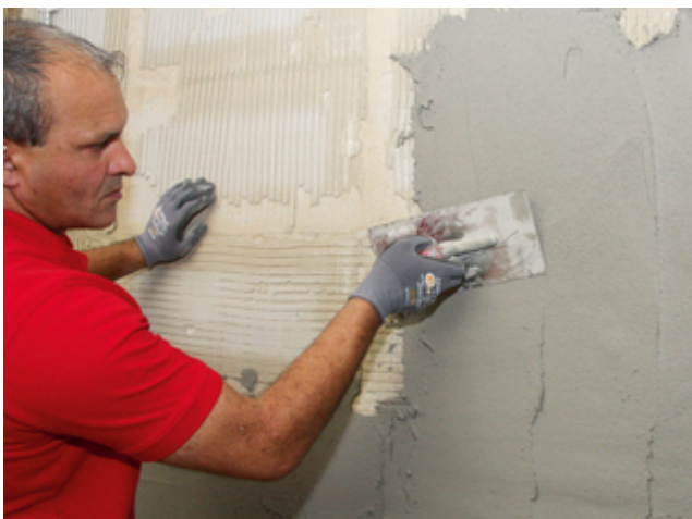
9. Alternativ kann Sopro RAP 2® mit der Glättkelle aufgebracht werden.
