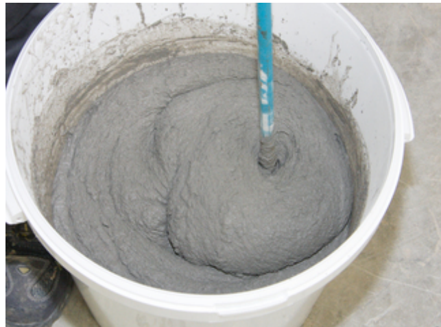
4. Sopro RAP 2 ® maschinell knollenfrei anmischen. Nach einer Reifezeit von 3 – 5 Minuten erneut durchmischen.
