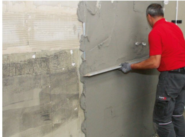
8. Anschließend den Putz mit einer Latte über die Putzschienen sauber von unten nach oben abziehen.
