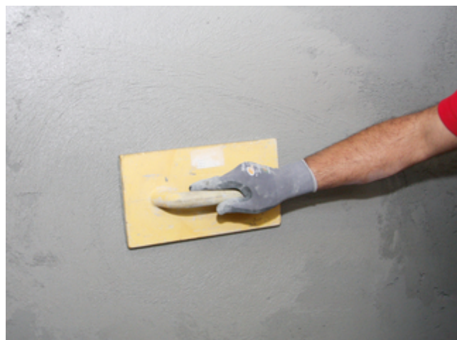
12. ... oder einer Holzscheibe nachgerieben werden, um so besonders glatte Oberflächen zu erzielen.
