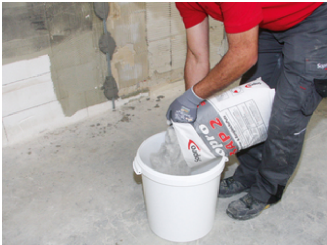
3. In einen sauberen Anmischeimer Wasser vorgeben, anschließend das Pulver zugeben.
