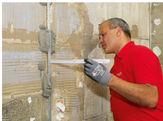
6 ... je nach gewünschter Putzstärke die Schienen mit entsprechendem Abstand zur Wand einbetten, gerade ausrichten und den Mörtel erhärten lassen.
