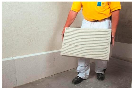
Die erste Reihe muss **lot- und fluchtgerecht** angelegt werden, damit die nächstfolgenden Dämmplatten fugenfrei verlegt werden können. Der **Fugenversatz** bei der übereinanderliegenden Schichten beträgt > **15cm**. Bei Fenster- und Türecke werden die Platten ausgeklinkt, so dass in den Ecken keine Dämmstoffugen vorhanden sind.
