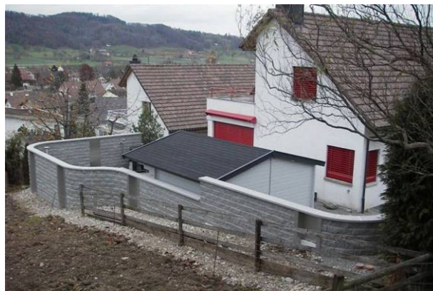
Bild 2: Doppelspaltsteine, eingesetzt als freistehende Mauer
