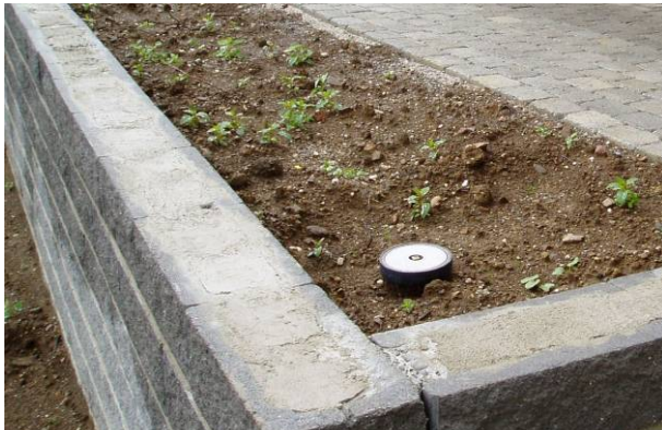
Bild 61: Vorbereitete Mauerkrone
