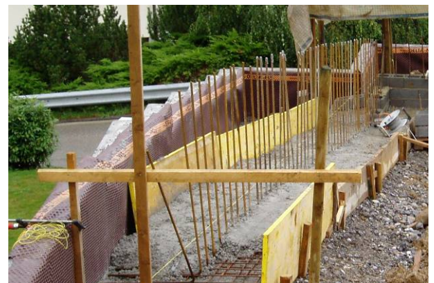
Bild 35: Fundament mit Anschlussbewehrung
