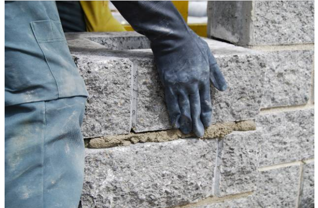
Bild 59: Versetzen von Pfeilerspaltsteinen
