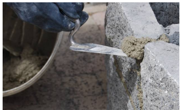
Bild 45: Entfernen von überschüssigem Mörtel
