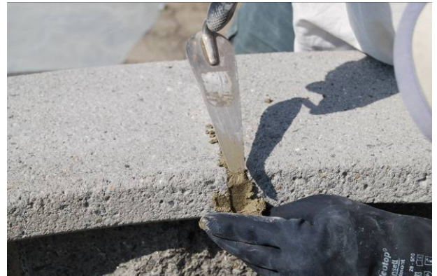
Bild 64: Verfugen der Abdeckplatten
