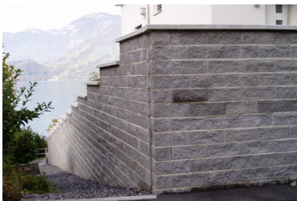
Bild 1: Spaltsteine, eingesetzt als Hangsicherung
