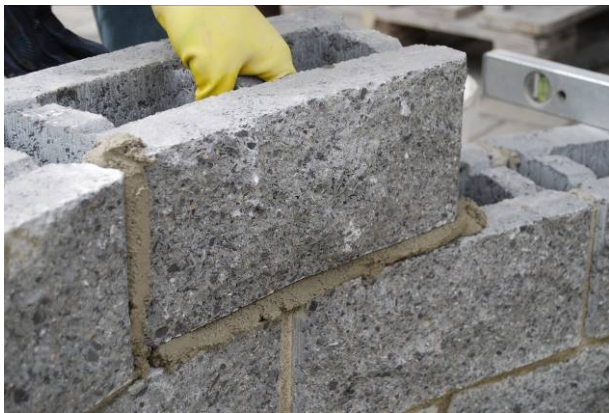
Bild 57: Versetzen von Radiussteinen
