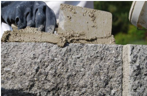
Bild 62: Erstellen der Mörtelvorlage
