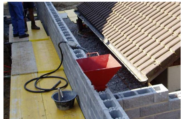
Bild 50: Einbringen von Füllbeton mit einem geeigneten Trichter
