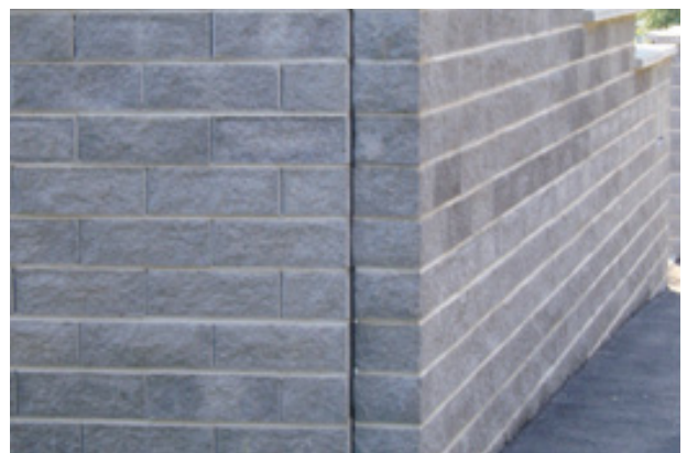
Bild 56: Vertikale Dilatationsfuge bei einer Eckausbildung
