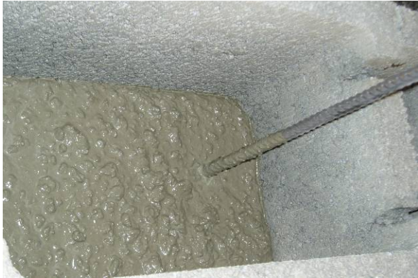
Bild 51: Füllhöhe bei der obersten Lage pro Betonieretappe
