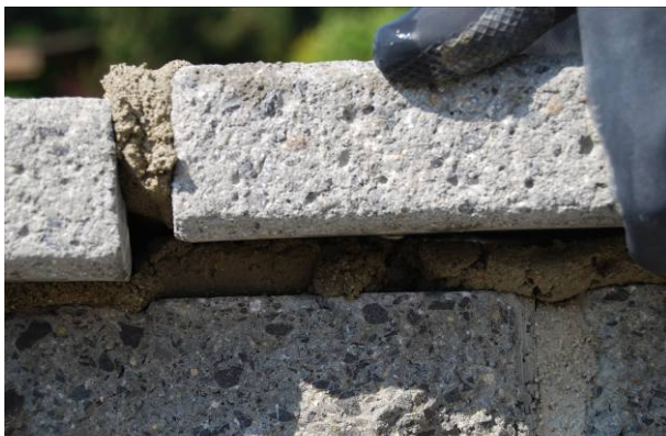
Bild 63: Versetzen der Abdeckplatten
