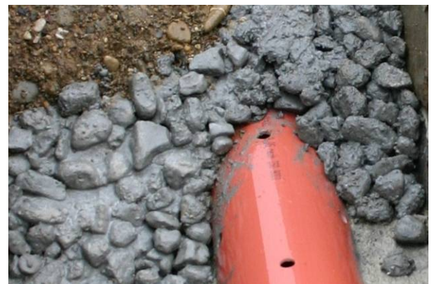
Bild 33: Eingebaute Sickerleitung
