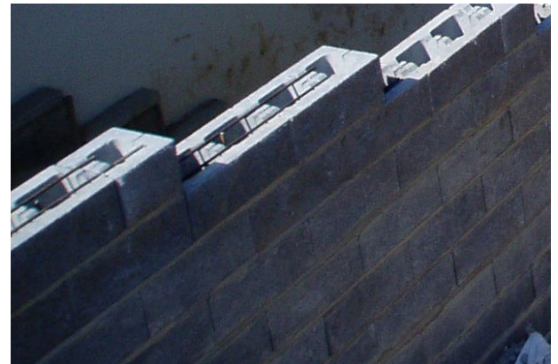
Bild 49: Bewehrungseinlagen, eingelegt in die vorgesehene Nuten
