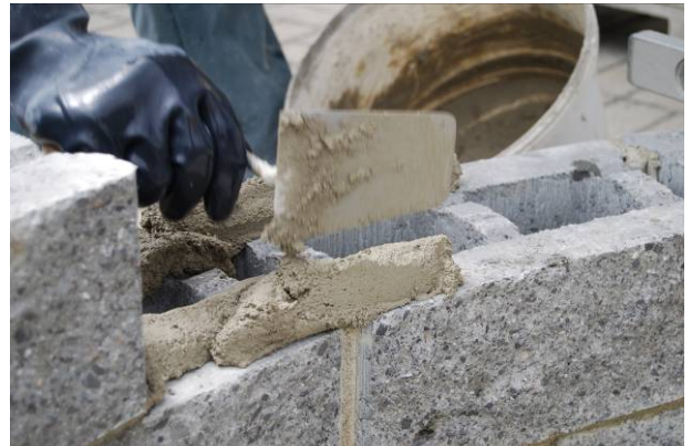
Bild 42: Aufbringen der Mörtelschicht
