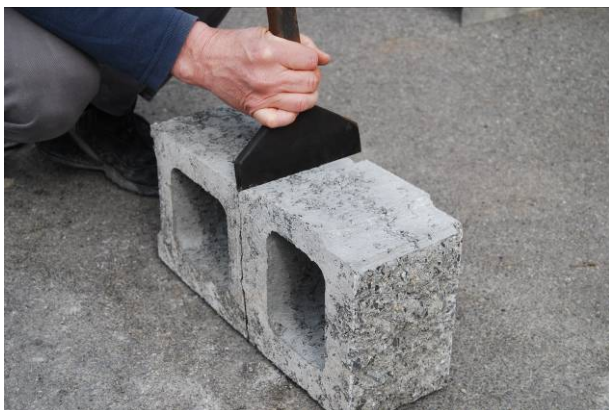
Bild 53: Trennen der Spaltsteine mit Meissel
