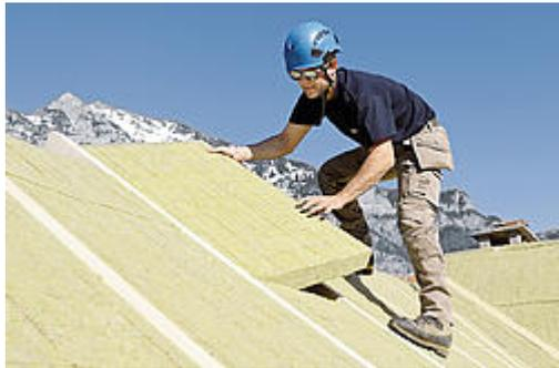
Zweischichtige Dämmplatte mit elastischer Unter- und härterer Aussenschicht. Steildachdämmung über den Sparren, zwischen Lattungen sowie für das Flumser- oder Eigerdach. Estrichbodendämmung (Dachboden) unter Verlegeplatten.
