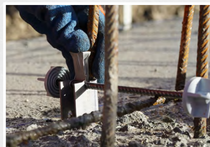
Der Keil kann einfach von Hand vorgesteckt werden
